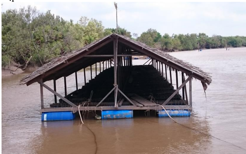
Bè hàu đã hoàn chỉnh và được đưa vào sử dụng ảnh: HN
